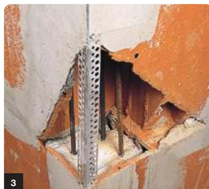
Le montage du **carrobric** de 15 cm est réalisé systématiquement au liant-colle maçonnerie **carrobric**. Le **carrobric** de 15 cm offre la possibilité d'incorporer des armatures verticales et horizontales, ainsi que des poteaux d'angles. Le **carrobric** de 15 peut être utilisé en extérieur. De plus, son classement en catégorie A permet l'utilisation d'enduits lourds, y compris monocouche. Réserve : **1** - Chaînage horizontal : **2** - Poteaux d'angles : **3** .
