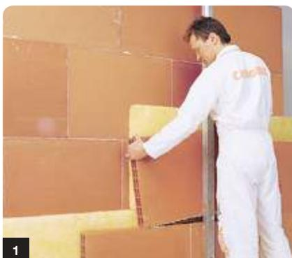
Réaliser, pour chacune des 2 cloisons, une désolidarisation périphérique à l'aide d'une bande résiliente caoutchouc. Après avoir monté la 1<sup>ère</sup> cloison, plaquer la laine de verre et monter la 2<sup>nde</sup> cloison.
