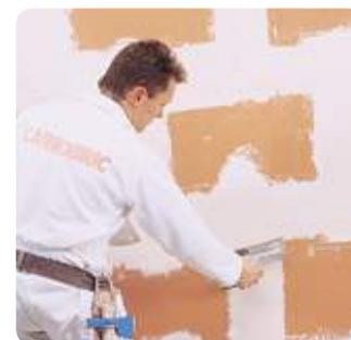
Les joints sont traités sur une grande largeur. Ils sont exécutés au liant-colle à l'aide d'un plateau ou d'un couteau. Dans le cas d'un revêtement épais (**carrofeu**), carrelage... ils seront simplement coupés au séchage.
