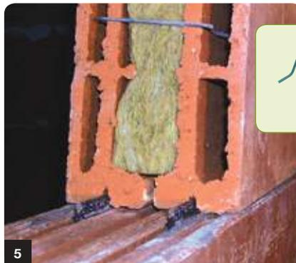
Lorsque les coupes sont réalisées sur les éléments **isophon** ou **carrophon** (harpage ou jonctions en angle), il se peut que les 2 parements se séparent.
