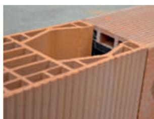
Posez le coffre. Découpez le poteau pour assurer la liaison béton entre le chaînage vertical et horizontal. 2 solutions : avec le poteau réservation de 15 ou le double poteau.
