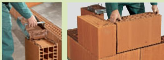
Pour éviter un jour entre produits lors du démarrage sur une brique poteau, mettez du mortier joints minces sur la tranche du produit avant la pose.
