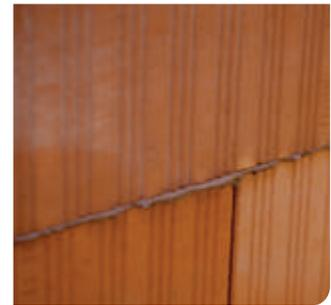
Humidifiez la brique. Attendez 5 min avant la dépose du mortier.
