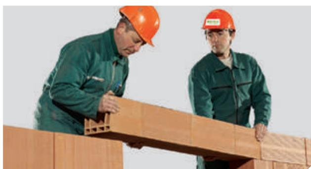
Le linteau grande longueur est un élément monobloc permettant la réalisation facilitée des linteaux d'ouverture en une seule opération.
