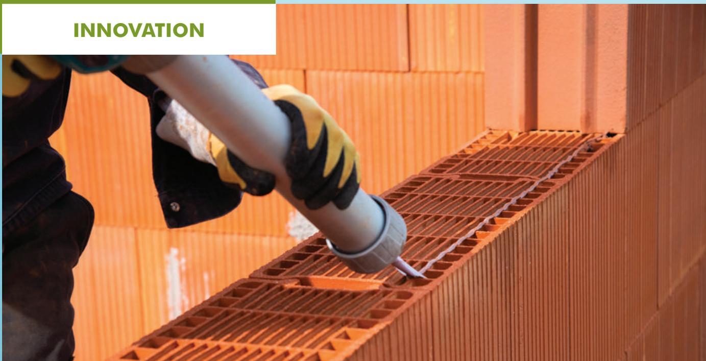
**fix'bric** est un liant polymère hybride prêt à l'emploi pour l'assemblage durable des briques de la gamme **bgv<sup>20</sup>** (briques et accessoires).
