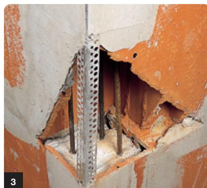
Le montage du **carroblic** de 15 cm est réalisé systématiquement au liant-colle maçonnerie **carroblic**. Le **carroblic** de 15 cm offre la possibilité d'incorporer des armatures verticales et horizontales, ainsi que des poteaux d'angles. Le **carroblic** de 15 peut être utilisé en extérieur. De plus, son classement en catégorie A permet l'utilisation d'enduits lourds, y compris monocouche. Réserve : **1** - Chaînage horizontal : **2** - Poteaux d'angles : **3** .
