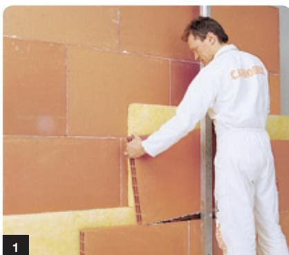
Réaliser, pour chacune des 2 cloisons, une désolidarisation périphérique à l'aide d'une bande résiliente caoutchouc. Après avoir monté la 1<sup>ère</sup> cloison, plaquer la laine de verre et monter la 2<sup>nd</sup>e cloison.
