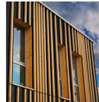
Pour ce même bâtiment avec une façade rideau réalisée en ossature bois, l'impact environnemental est comparable à la solution brique : **-11,7 kg de CO<sub>2</sub>/m<sup>2</sup> de SHAB** (-1,5% d'IC<sub>construction</sub>).
